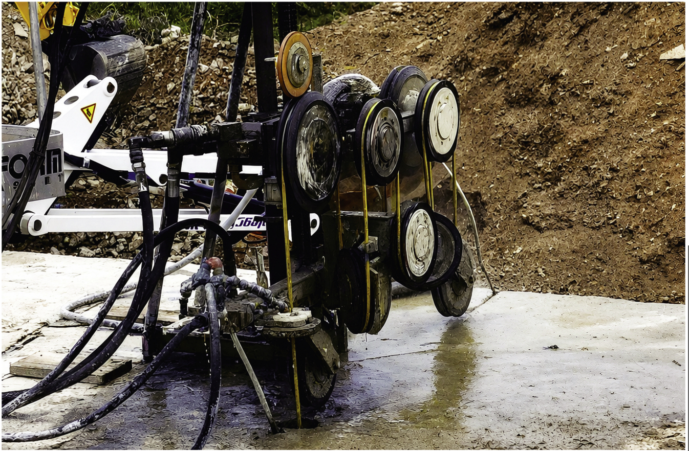
Taglio a filo diamantato su soletta: la gestione dello spazio operativo è parte integrante della lavorazione Diamond wire cutting on a concrete slab: managing the operational space is an integral part of the job
