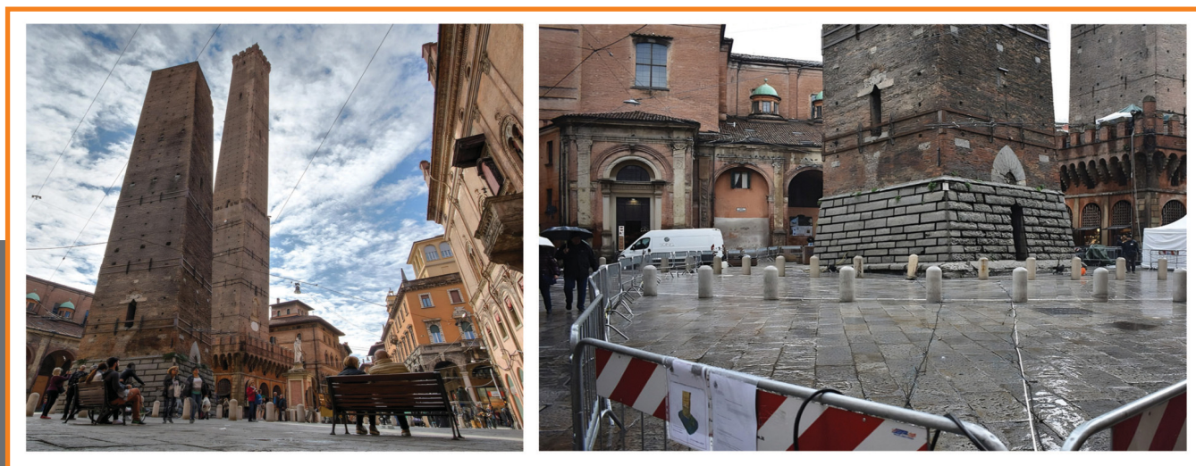
Fig.6 Torre Garisenda e Torre degli Asinelli a Bologna. Blocchi di selenite deteriorati al piede della Torre Garisenda The Garisenda and Asinelli Towers in Bologna. Deteriorated selenite blocks at the base of Garisenda Tower
