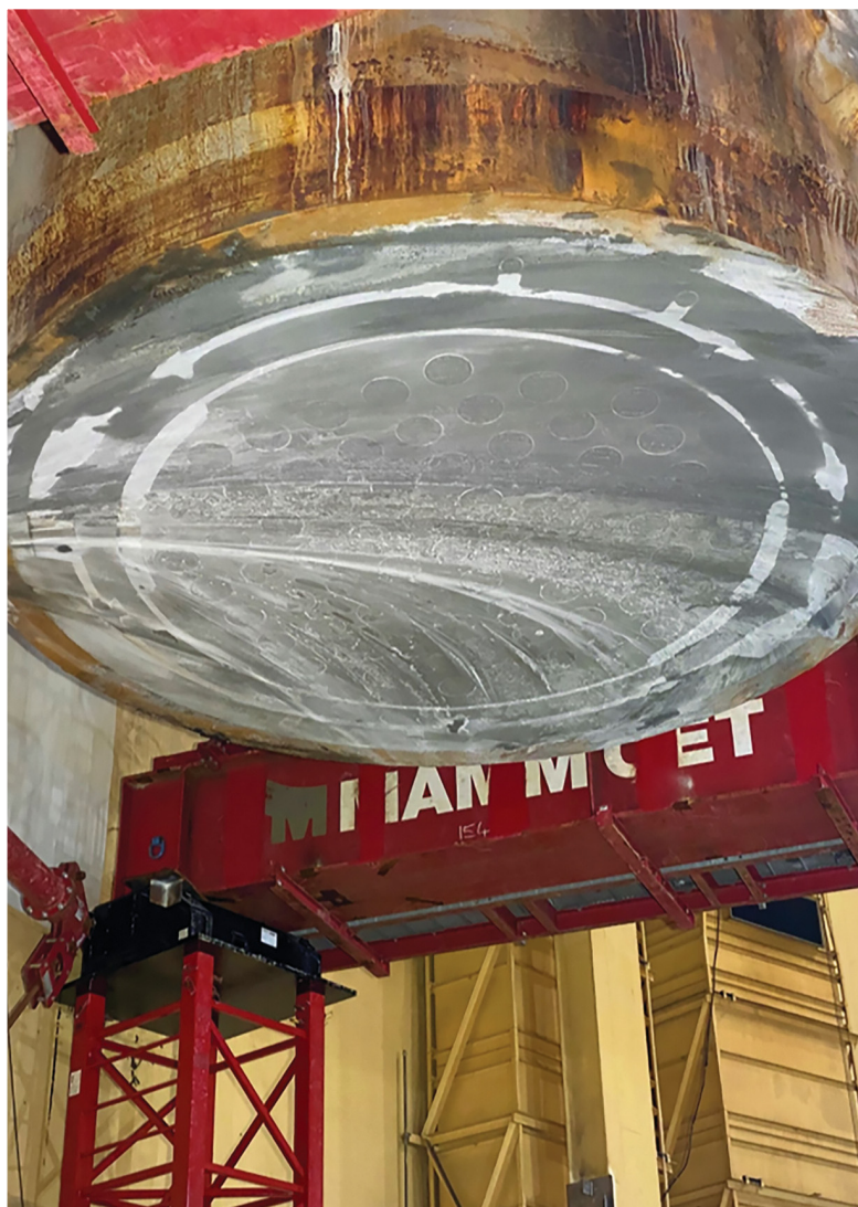
Vista del primo taglio orizzontale, base della sezione superiore del recipiente del reattore View of first horizontal cut, looking at bottom of upper section of reactor vessel
