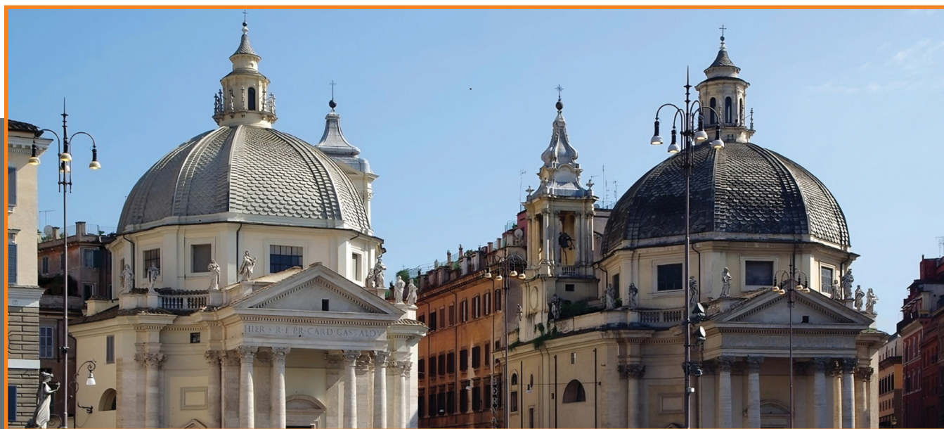
Fig.9 Differenza cromatica delle coperture di ardesia delle chiese "gemelle" di Piazza del Popolo, Santa Maria in Montesanto e Santa Maria dei Miracoli Chromatic difference of the slate roofs of the twin churches in Piazza del Popolo, Santa Maria in Montesanto and Santa Maria dei Miracoli
