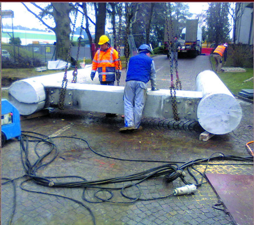
14. Movimentazione e messa al piano del blocco pilastri/trave Placing on the ground of the pillar/beam concrete structure
