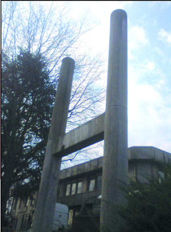
3. Struttura in cemento armato liberata della passerella in legno The concrete structure freed from the wooden walkway
