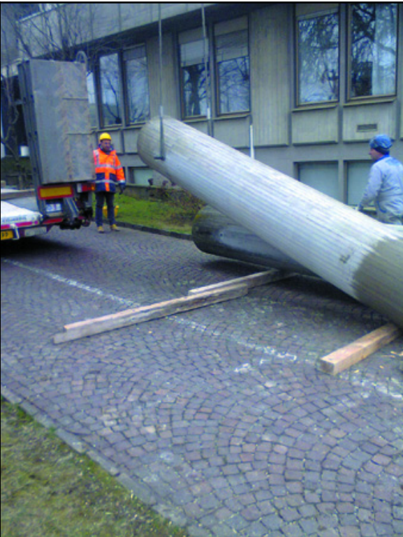
11. Deposito provvisorio a terra delle due metà pilastri The two sawed parts have been laid on the ground
