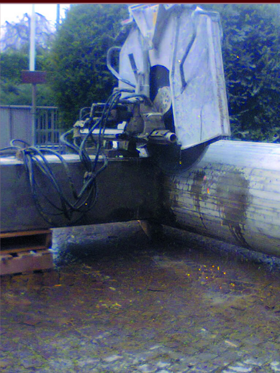
15. Distacco del primo pilastro dalla trave di collegamento Detachment of the structural beam from the first pillar
