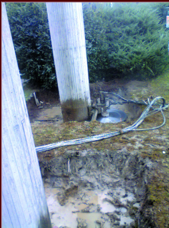
13. Sezionamento al piede del secondo pilastro Disc sawing at the base of the second pillar
