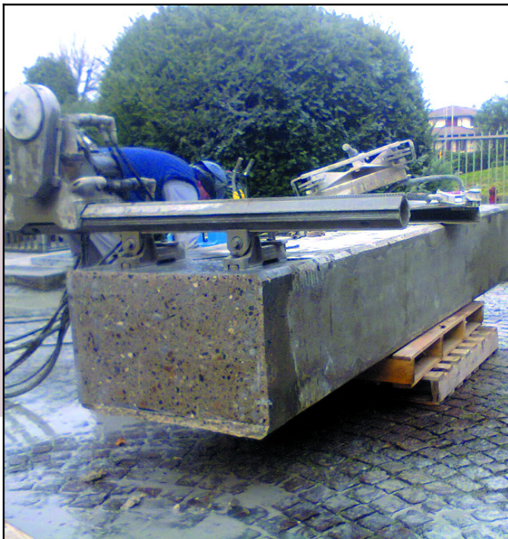
17. Trave di collegamento rimanente The remaining structural beam
