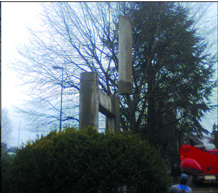
10. Movimentazione di metà del secondo pilastro Lifting of the sawed part of the second pillar
