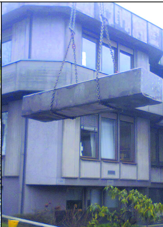
18. Movimentazione della trave Lifting of the structural beam
