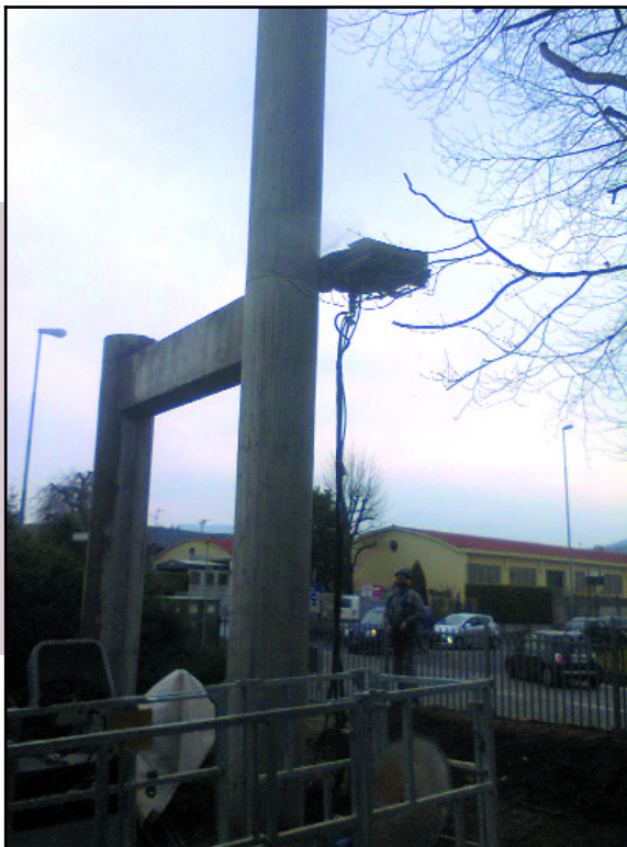
9. Sezionamento di metà del secondo pilastro Disc sawing of the second pillar into halves
