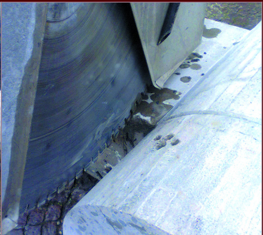
16. Distacco del secondo pilastro dalla trave di collegamento Detachment of the structural beam from the second pillar
