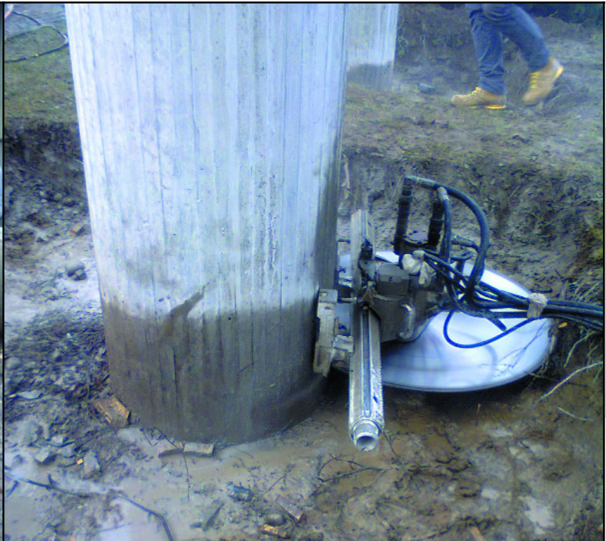
12. Sezionamento al piede del primo pilastro Disc sawing at the base of the first pillar
