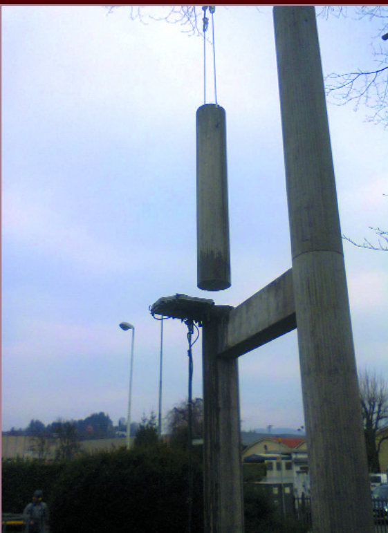
7. Movimentazione della metà del primo pilastro Lifting of the sawed part of the first pillar
