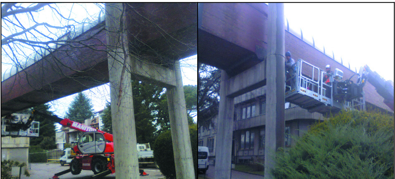
1. Vista della passerella pedonale in appoggio sulla struttura in cemento armato durante la fase di preparazione View of the wooden walkway on the concrete structure during the preparation phase
