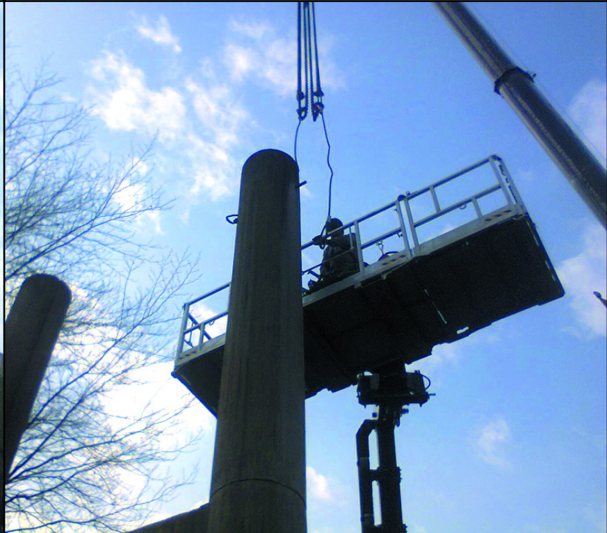
4. Predisposizione imbracco Lifting preparation
