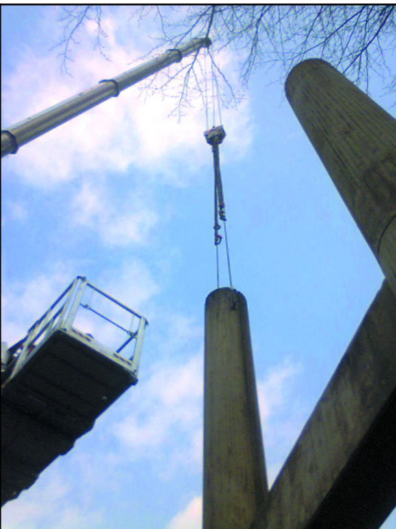
5. Messa in tensione del primo pilastro Tensioning of the first pillar
