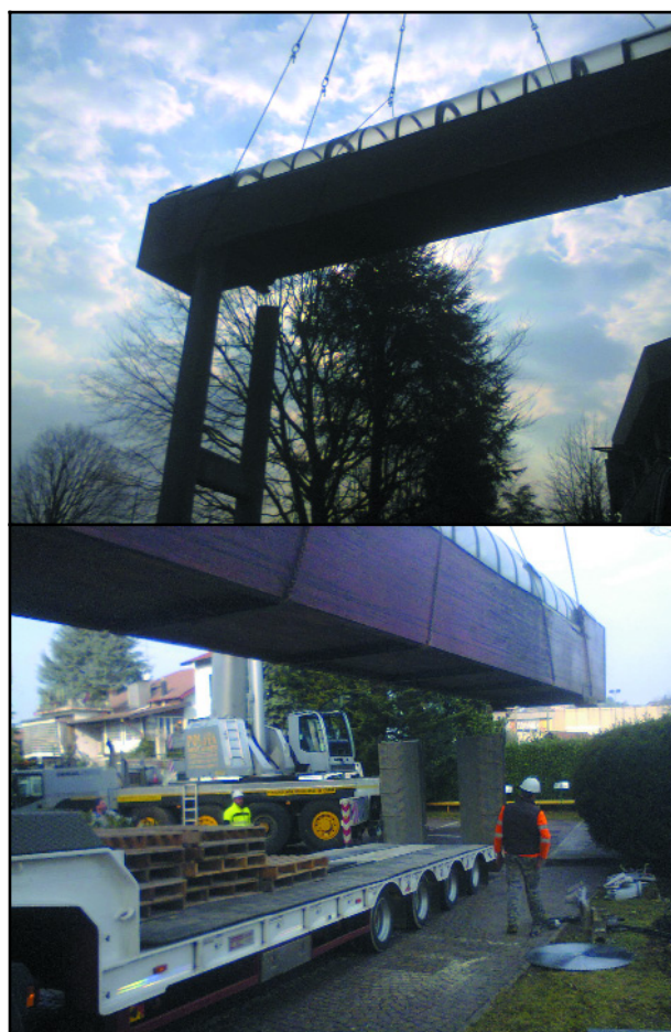
2. Fasi di movimentazione della passerella in legno Handling phases of the wooden walkway
