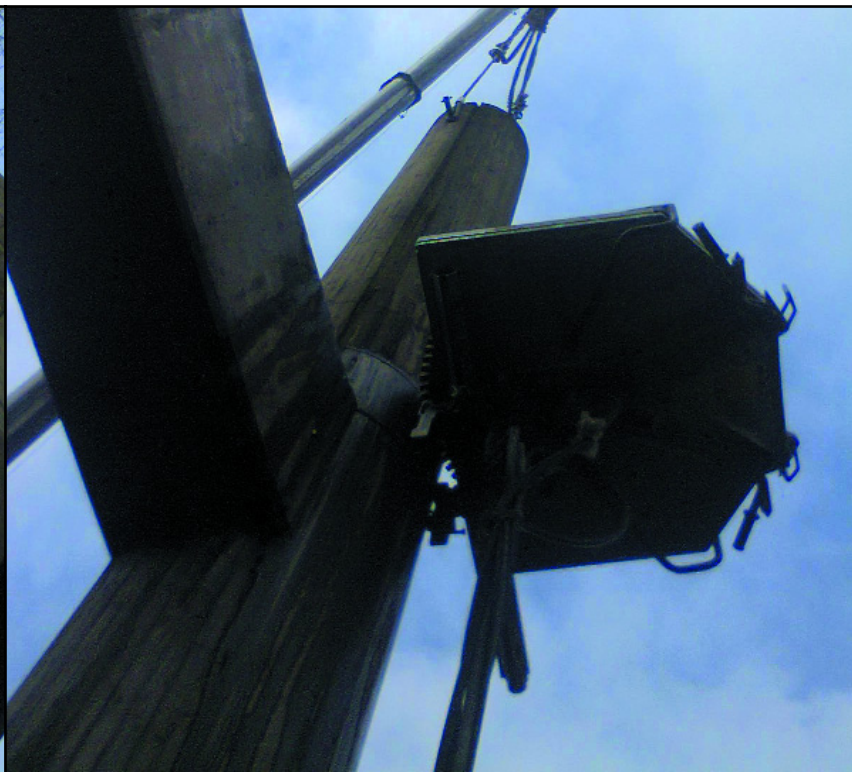
6. Sezionamento di metà del primo pilastro Disc sawing of the first pillar into halves
