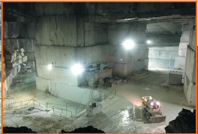
**Fig.1b** Cava Fantiscritti. In posizione centrale si osserva un pilastro, lasciato in posto a sostegno dei vuoti di coltivazione
