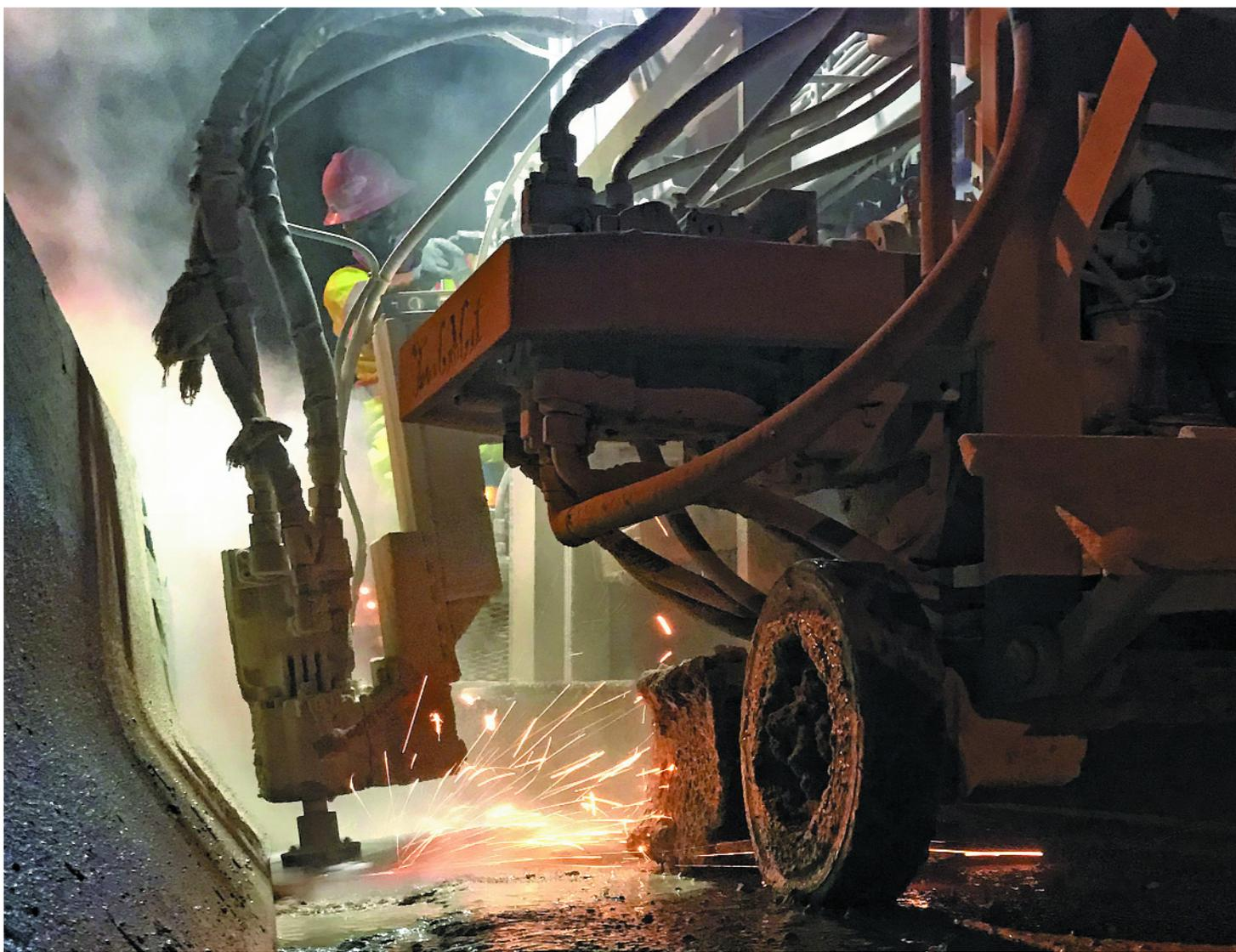
Volano scintille mentre la macchina della Texas Curb Cut seziona la barriera spartitraffico spessa 60 cm
