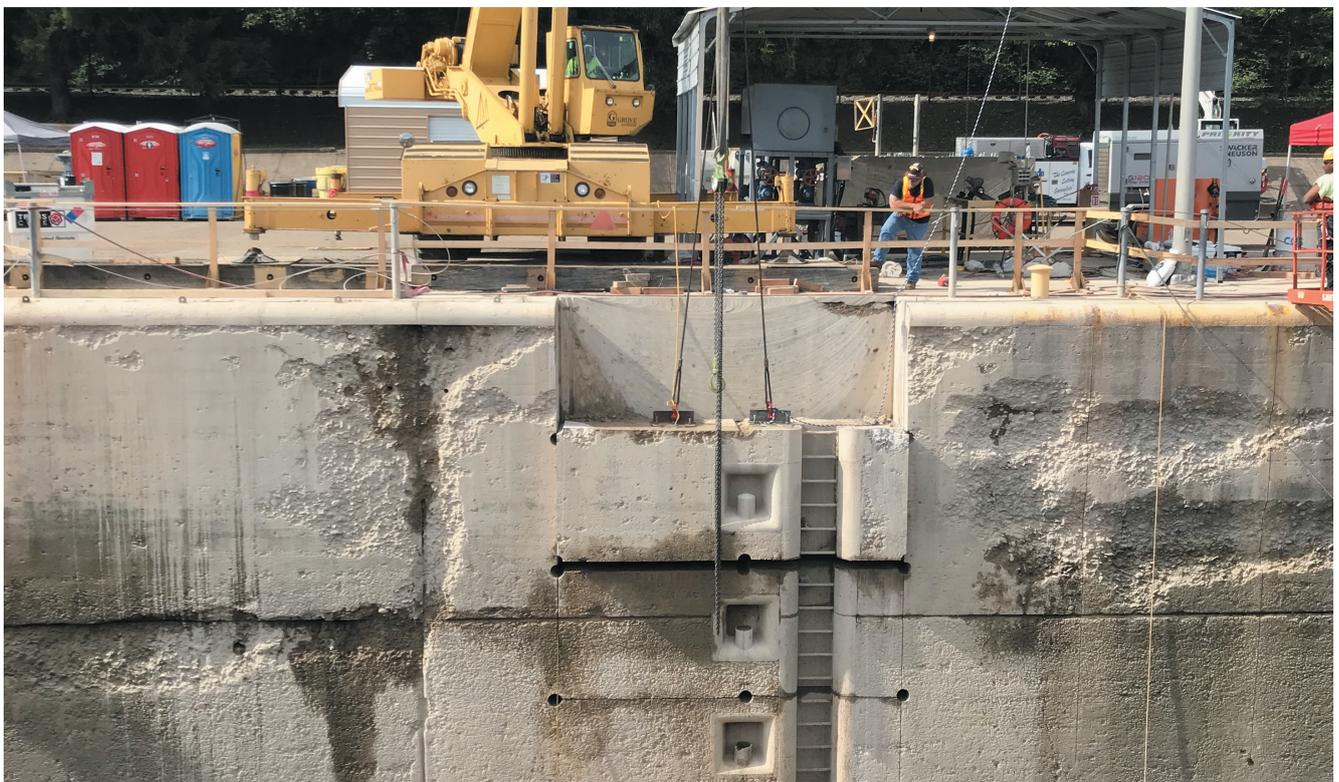
Parte della sezione in calcestruzzo di 100 x 6,7 metri sezionata e rimossa con una gru
