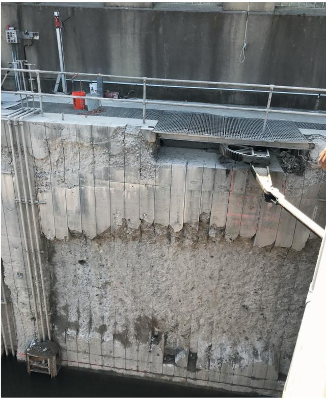
In totale, sono stati realizzati circa 450 metri lineari di taglio con le tagliamuro
