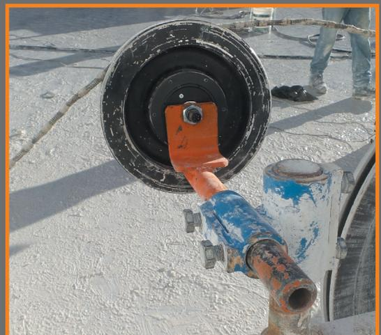
Fig.19 Cella di carico installata con indicatore verso il basso e fune su lato superiore / Load cell installed with the indicator down and the rope on the upper side
